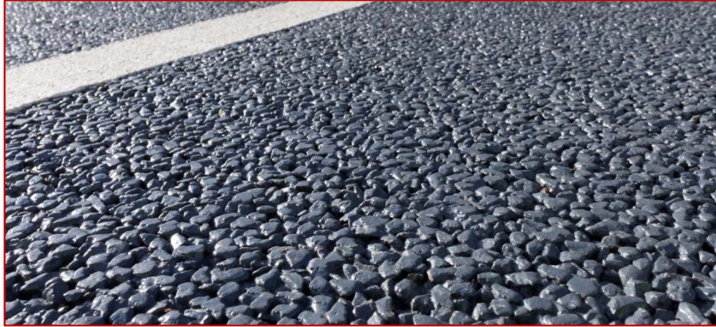
شكل رقم (14) خرسانة خالية من الرمل مستخدمة في رصف طريق
